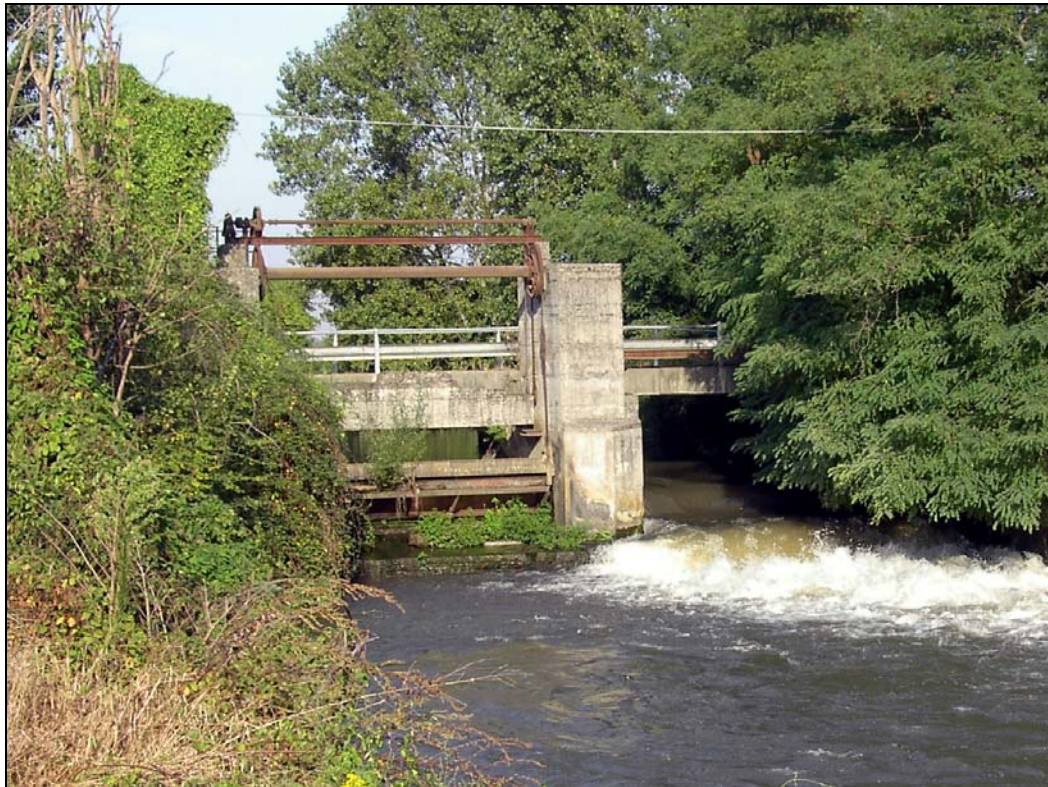
Fig. 4 Traversa fluviale sul fiume Olona a Sud di Vistarino
